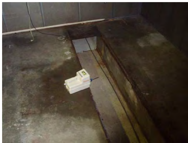
10.) Trench, Burn Room 1
