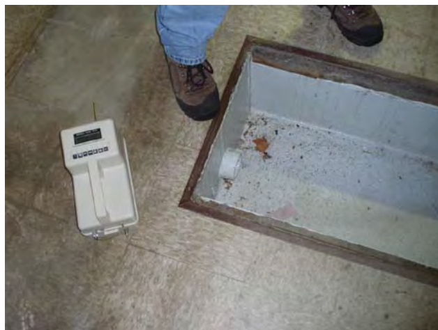
12.) Trench at Pipe, Area 2
