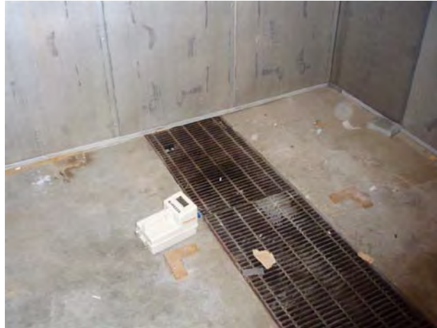
11.) Trench, Burn Room 2
