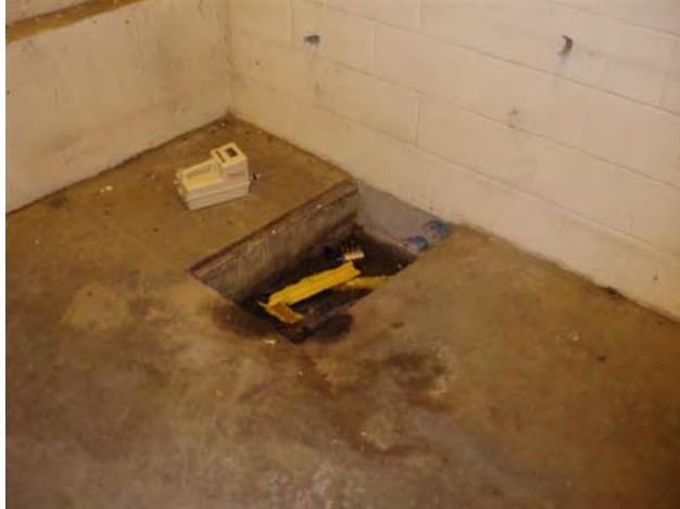
1.) Test cell 1, Trench
